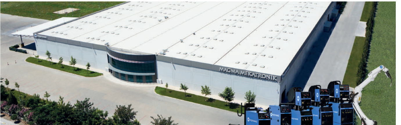
Kaynak Makineleri ve Robotik Sistemler Fabrikası Organize Sanayi Bölgesi 5. Kısım, Manisa
